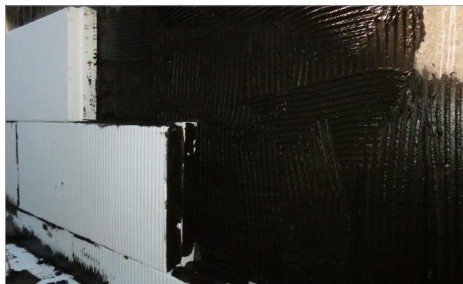
Klebeauftrag auf Untergrund (Beton oder Bitumenabdichtung)
