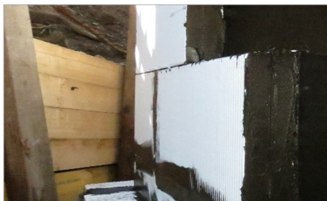
Klebeauftrag stirnseitig auf Dämmplatte im Bereich Stufenfalsch
